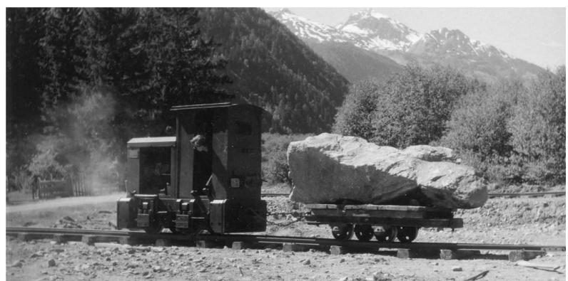
Trasporto dei massi mediante una ferrovia decauville provvisoria
