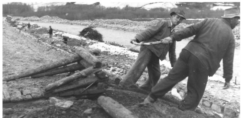
Rimozione dei detritici con l'uso di slitte in legno e argano a cavo
