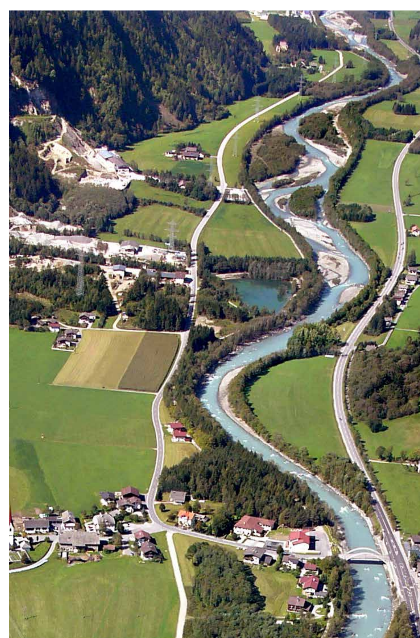
Widening in St. Johann im Walde: Length 2,500 m
