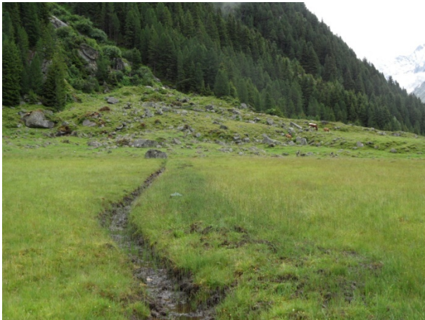
Abbildung 62: Entwässerungsgraben im Krimmler Achental
