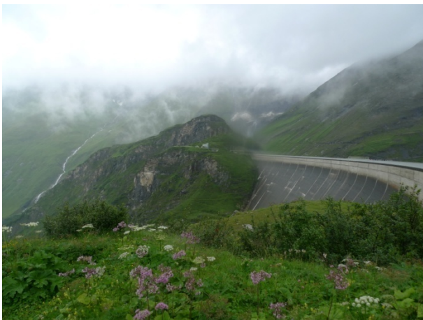
Abbildung 103: Blick auf die Staumauer
