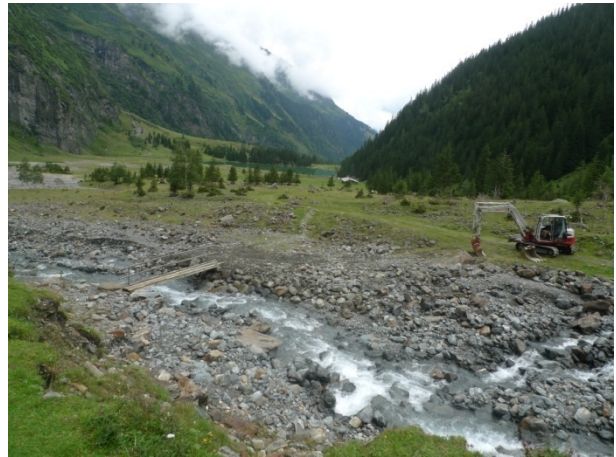
Abbildung 90: Beseitigung von Hochwasserschäden im Felbertal (Erneuerung der Brücke)
