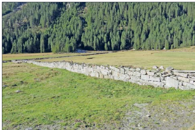
Sogfältig geschichtete Klaubsteinmauer (Steinhag)
