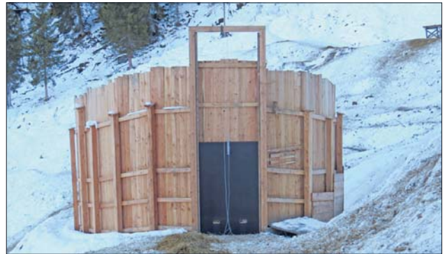
Bau des Fangkrals im Nationalpark-Revier Habachtal. Die Innenseite ist so gestaltet, dass sich Rotwild nicht verletzen kann. Die Seitenwände sind etwa 4 Meter hoch. Das Wild kann durch zwei Öffnungen in den Kral. Die Eingänge können mittels Falltüren geschlossen werden.
