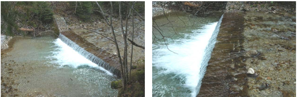
Abb. 19: Sohlschwelle ca. 500 m flussauf der Mündung in die Enns.
