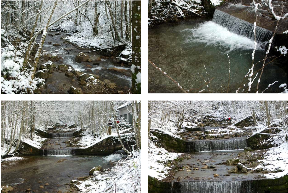
Abb. 8: Probestrecken 5 und 6: Gewässercharakteristik der Probestrecke 5 (oben links), Sohlstufe und Wehrkolk am oberen Ende der Probestrecke 5 (oben rechts), Blick Richtung Probestrecke 6 mit Triebwasserrückleitung (unten links) und Probestrecke 6 mit Sohlswellen (unten rechts).
