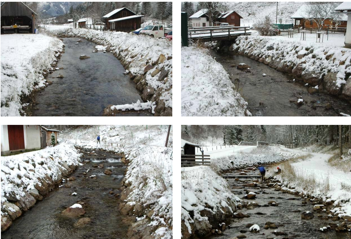
Abb. 10: Probestrecke 7: Streckenverlauf im unteren Streckenabschnitt (oben), Streckenverlauf im oberen Streckenabschnitt (unten links) und Sohlschwelle am oberen Streckenende (unten rechts).
